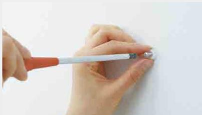
下地の位置に合わせて、取付けネジでブラケットを取付けてください。
