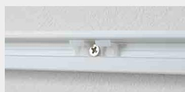
ベースにフロントカバーを固定するために、カバーストップを900mm間隔にて取付けてください。
