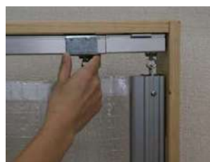
②カバーをずらして端部のレールを外す。
