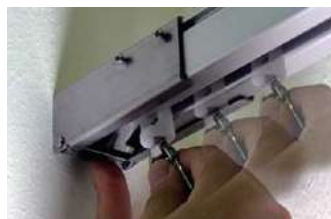
ランナー挿入後にハッチは自動で閉まります。
